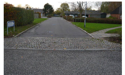
Den eksisterende stikvej fra Lyngsvinget, som bliver forlænget omkring en fælles grønning.
